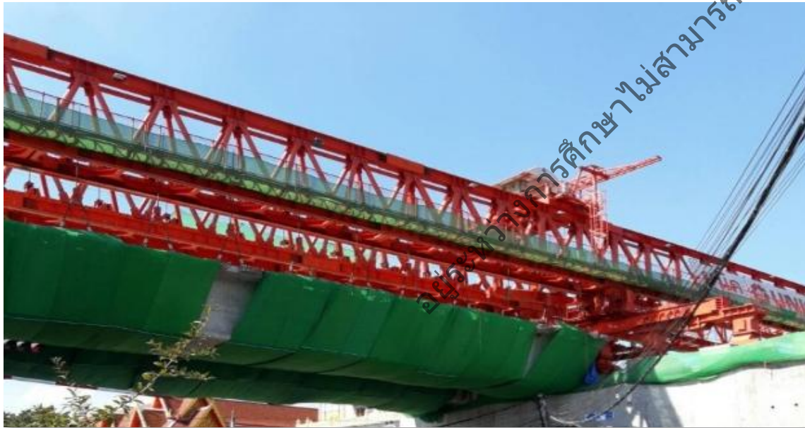
ติดตั้งตาข่ายใต้โครงสร้างสะพาน
