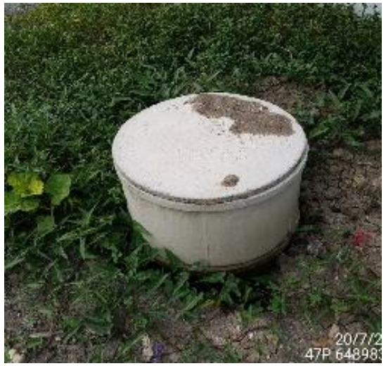
ติดตั้งระบบบำบัดน้ำเสีย
