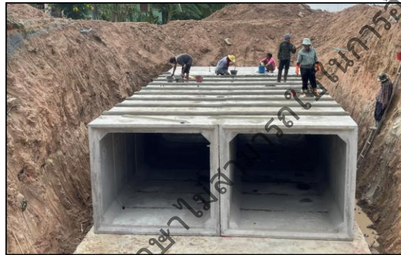
ตัวอย่างท่อลอดระบายน้ำแบบเหลี่ยม
