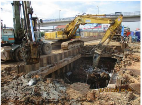
ก่อสร้างช่วงเวลากลางวัน 08.00-17.00 น.
