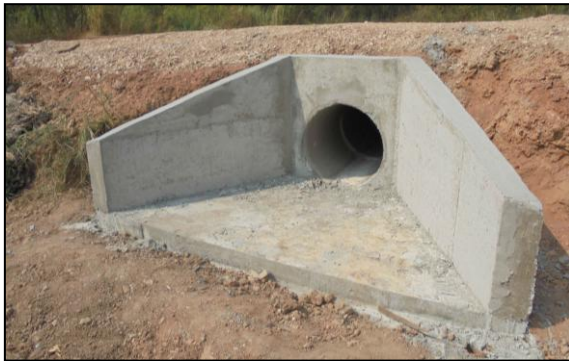
ตัวอย่างท่อลอดระบายน้ำแบบกลม
